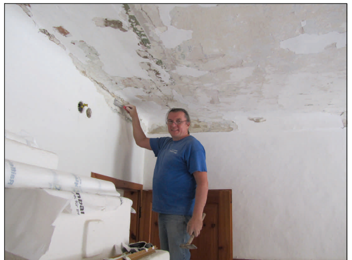
Alle Mauern mussten vom lockeren Putz bzw. Kalk mit z. B. Spachteln befreit werden, Vizebgm. Engelbert Freudenschuß half tatkräftig mit.
