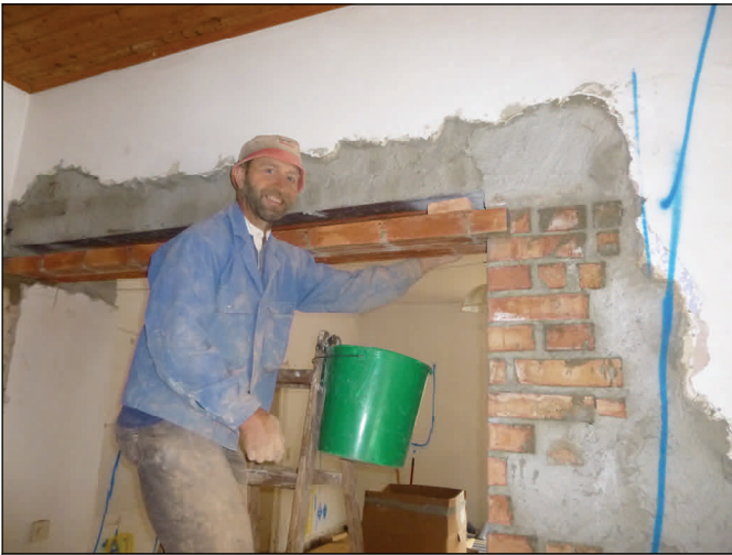
Josef Rosenthaler beim Einmauern der Überleger beim Eingang in den Pfarrsaal.
